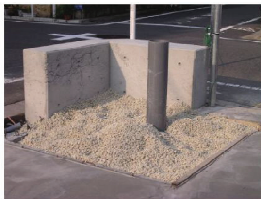
◆ スーパーソル敷き詰め状況①
