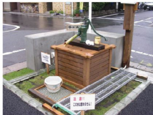
◆ 工事完成状況
