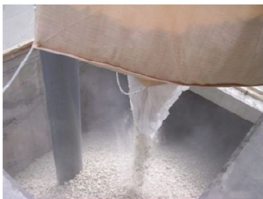
◆ スーパーソル投入状況
