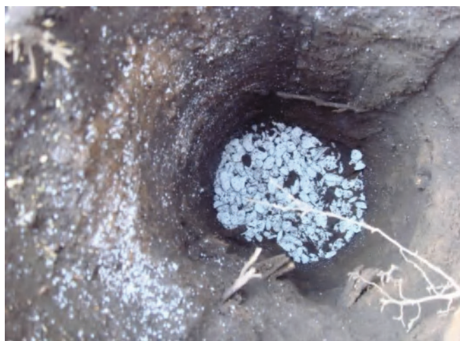
▲排水材としてスーパーソルを投入
