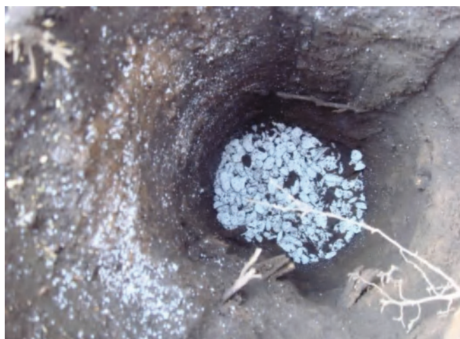
▲排水材としてスーパーソルを投入
