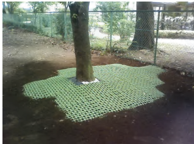
▲保護マット敷設
