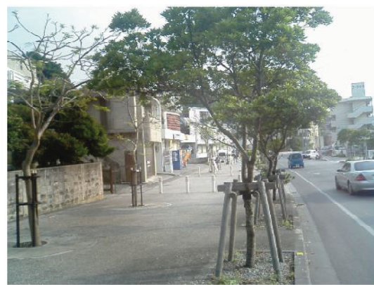
植栽完成から約3年経過状況
