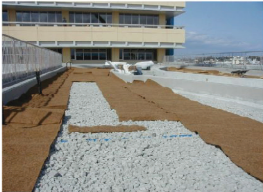
◆ スーパーソル搬入状況
