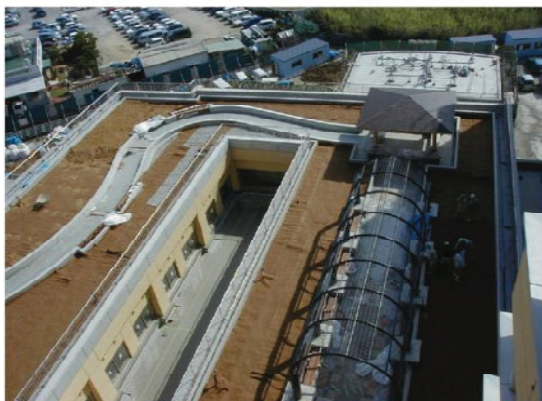
◆ スーパーソル敷き詰め状況
