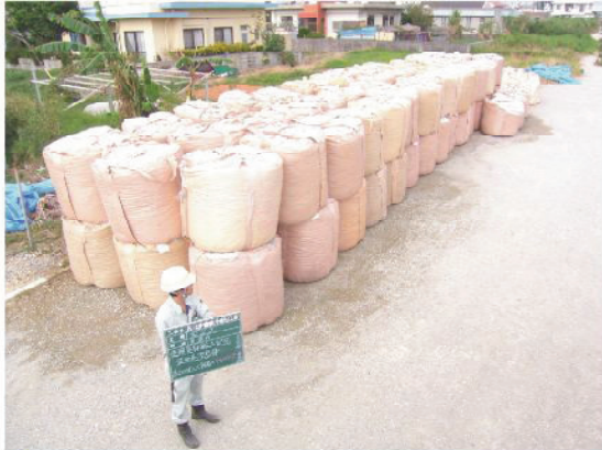
▲スーパーソル搬入状況
