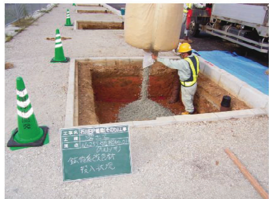
▲スーパーソル投入状況(排水層)
