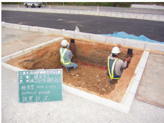
▲スーパーソルパイプ設置(1m)
