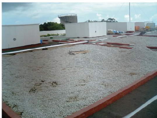
▲ グラストーン敷き込み状況
