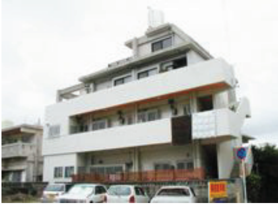
▲住宅（屋上に施工）
