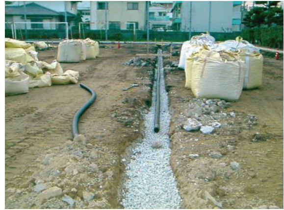
▲暗渠排水管埋設
