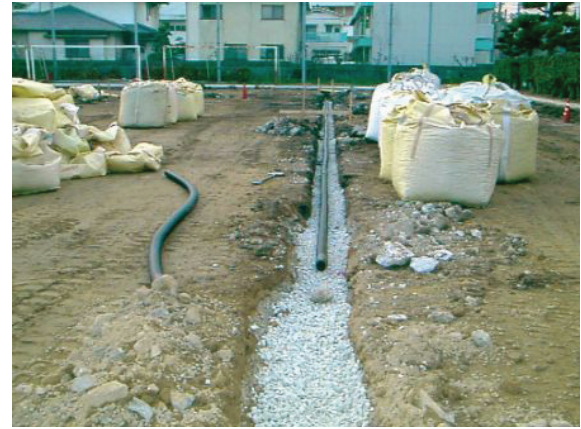
▲暗渠排水管埋設
